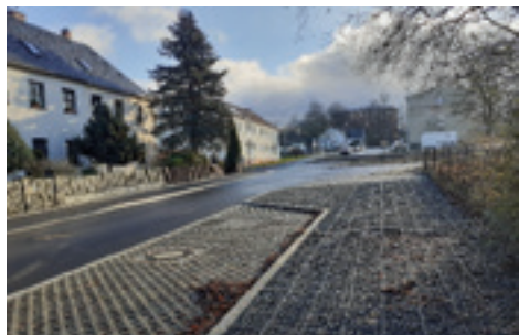
Dorstädter Straße Erneuerung Zufahrt Kabelwerk
