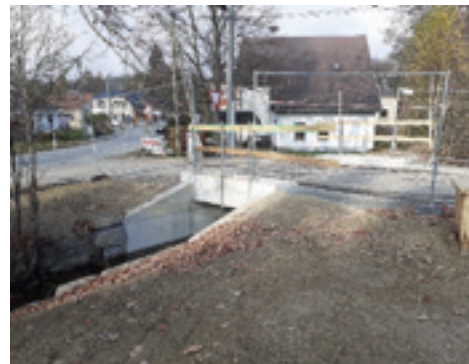
Brücke „Am Lohberg“ Erneuerung des Brückengeländers
